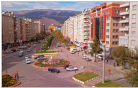
همجواری اسکلت‌های بتن آرمه و سازه‌های قدیمی مصالح بنایی در رده کوتاه یا میان مرتبه در شهرهای تحت تاثیر زلزله اخیر ترکیه
