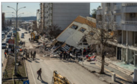
تخریب کلی ساختمانی در پازارچیک بر اثر وقوع طبقه نرم
