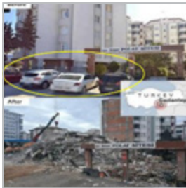
تخریب کلی ساختمانی در پازارچیک بر اثر وقوع طبقه نرم
